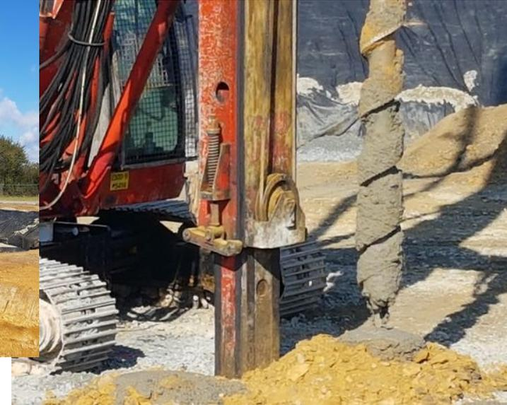
*La nature des sols est différente de ce que nous avons rencontré, à VEZINS. Les fonds de fouille doivent être renforcés par des injections de béton pour stabiliser et supporter la charge.*
