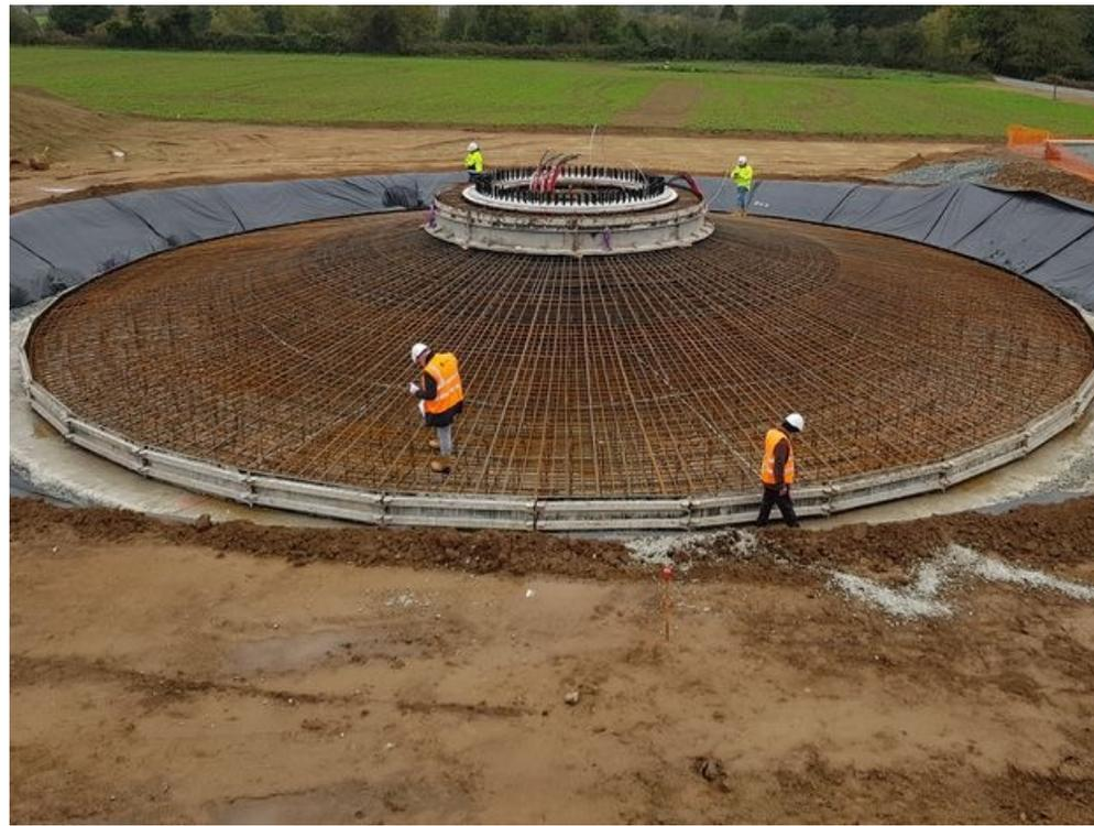
*Le ferrailage terminé est contrôlé par M. Baudry de l'APAVE.*
