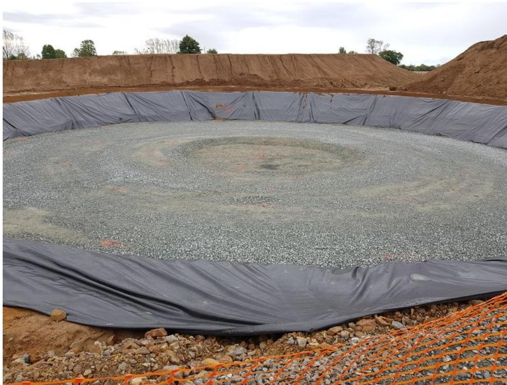
*Après avoir réalisé ce lit d'empierrement, tout est prêt pour réaliser le béton de propreté.*
