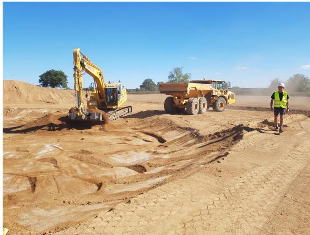
*Pelleteuses, brise-roche, camions-bennes s'activent pour préparer les massifs des fondations des 3 éoliennes.*
