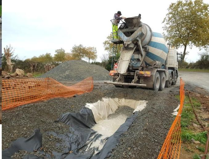
*Et toujours dans le respect de l'environnement, avec le nettoyage des toupies dans le bac de décantation prévu à cet effet !!!*
