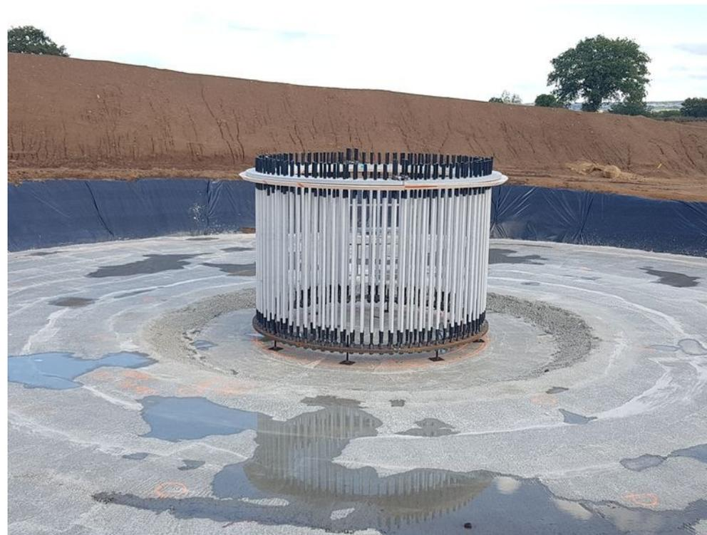
*La cage d'ancrage composée de 160 tiges filetées peut ainsi être posée.*
