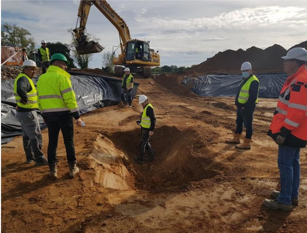
Purge de 7 m<sup>3</sup> demandée par M. **DITPAPIN** pour l'éolienne N°2, afin d'ôter les veines de kaolin.
