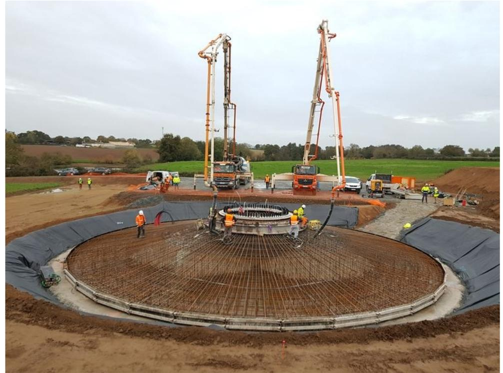
*488 m<sup>3</sup> de béton ont été aspirés par ces 2 pompes et déposés avec précision !!!*
