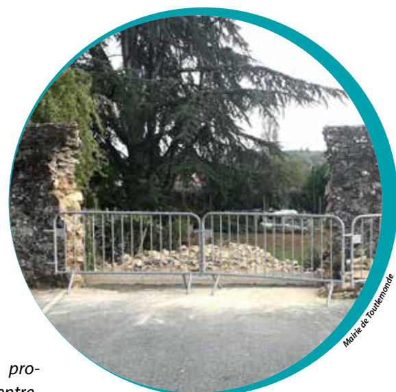
Les premiers travaux ont port   sur l'ouverture des murs actuels pour acc  der au terrain permettant la cr  ation de la liaison douce.
