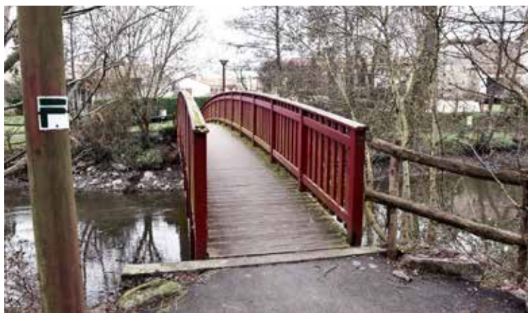
La peinture n'affiche pas une assez bonne tenue dans le temps sur le bois des garde-corps des passerelles.
